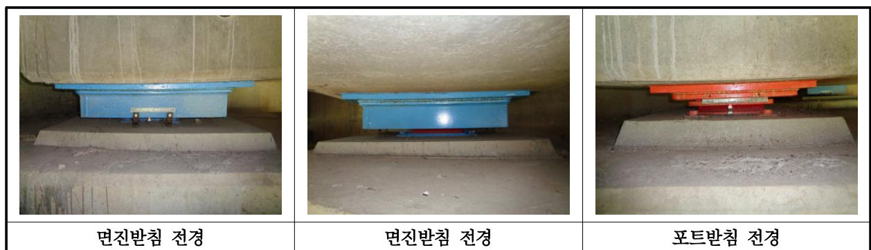
【사진 11.3.12】 교량받침 전경
