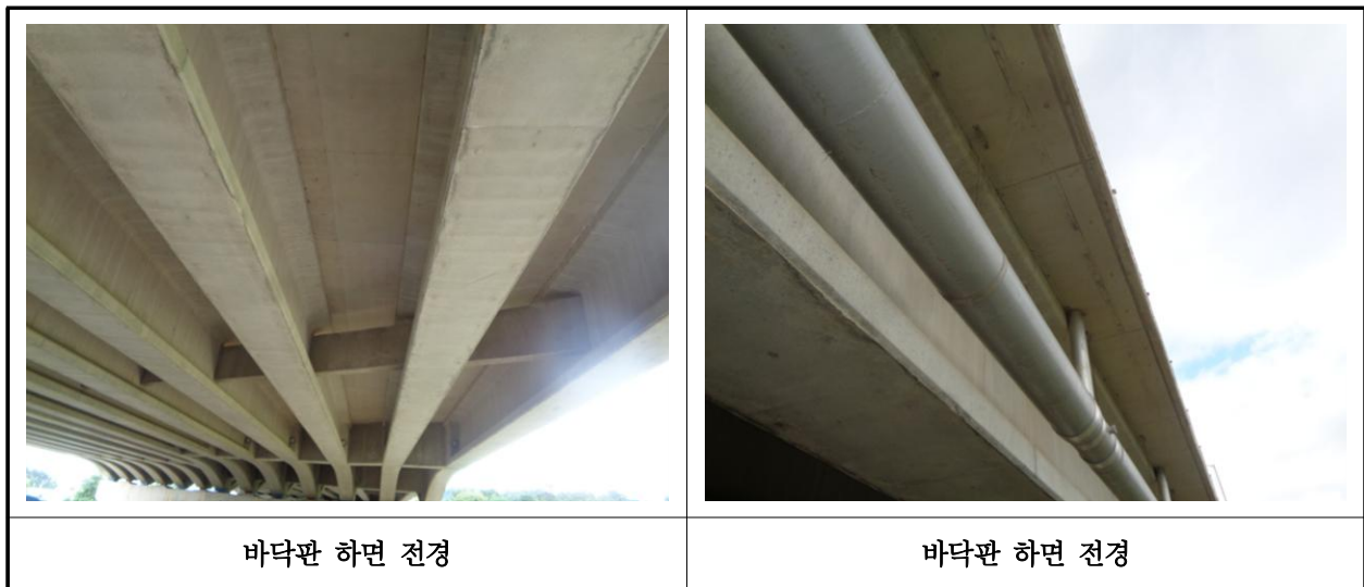
【사진 11.3.2】 바닥판하면 전경
