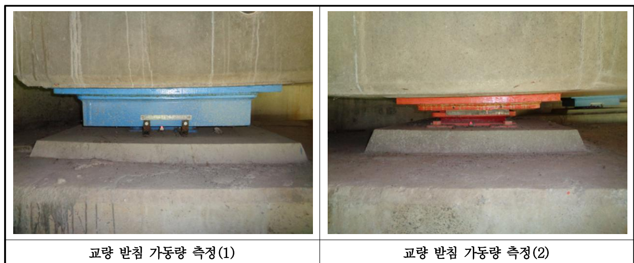
【사진 11.3.15】교량받침 이동량 측정
