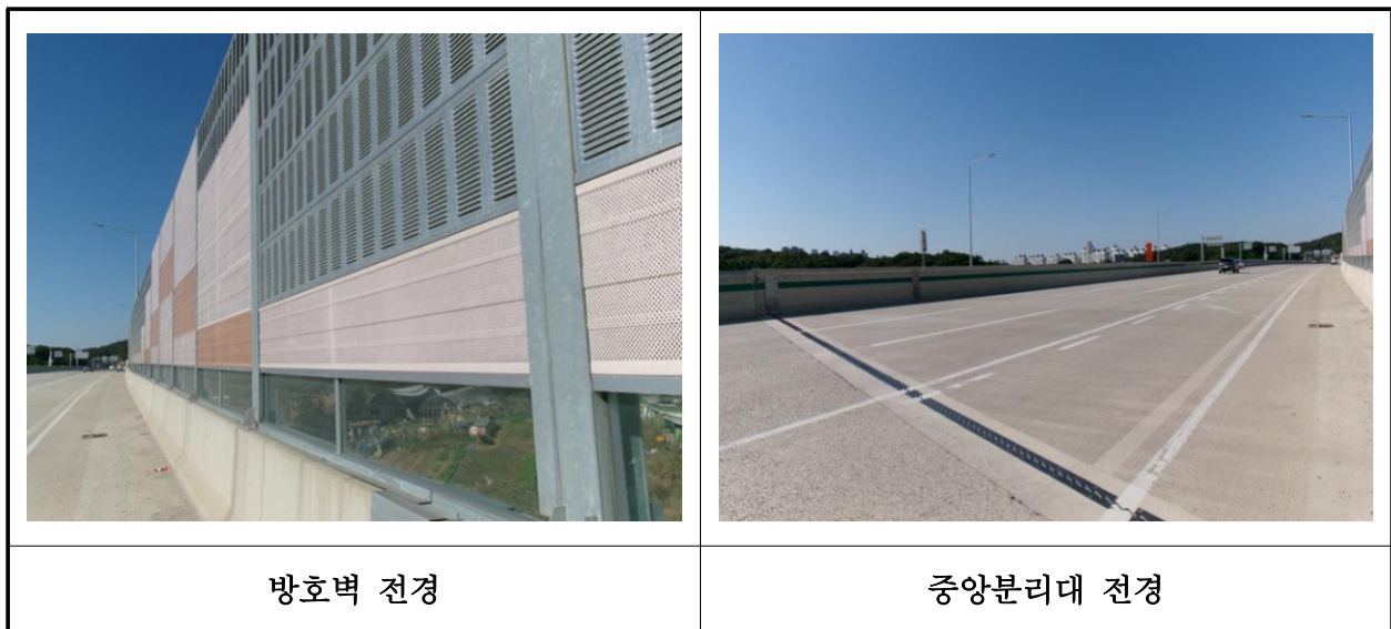
【사진 11.3.23】 방호벽 및 중앙분리대 전경
