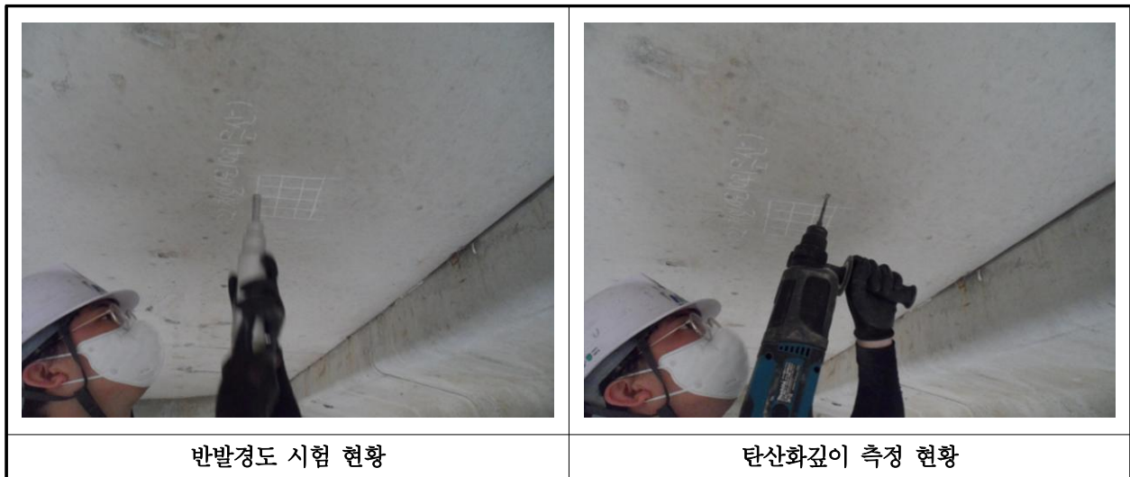
【사진 11.4.1】 콘크리트 내구성조사 현황
