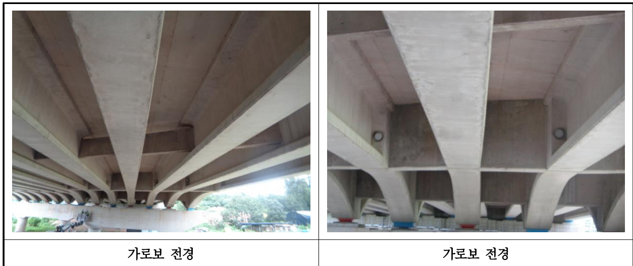
【사진 11.3.6】 가로보 전경
