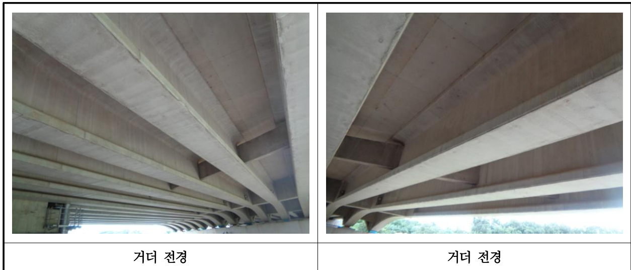
【사진 11.3.4】 거더 전경
