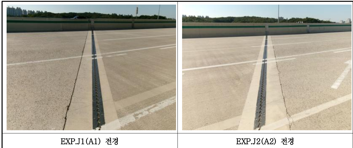
【사진 11.3.16】 신축이음장치 전경
