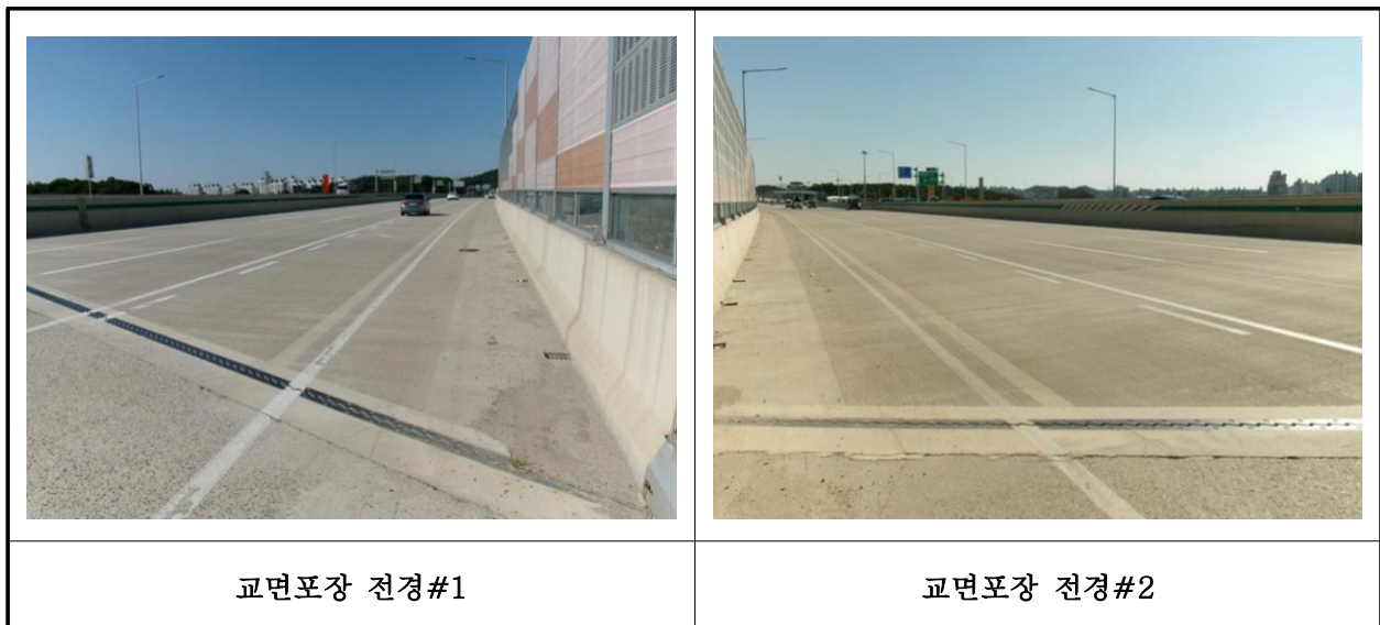
【사진 11.3.19】 교면포장 전경
