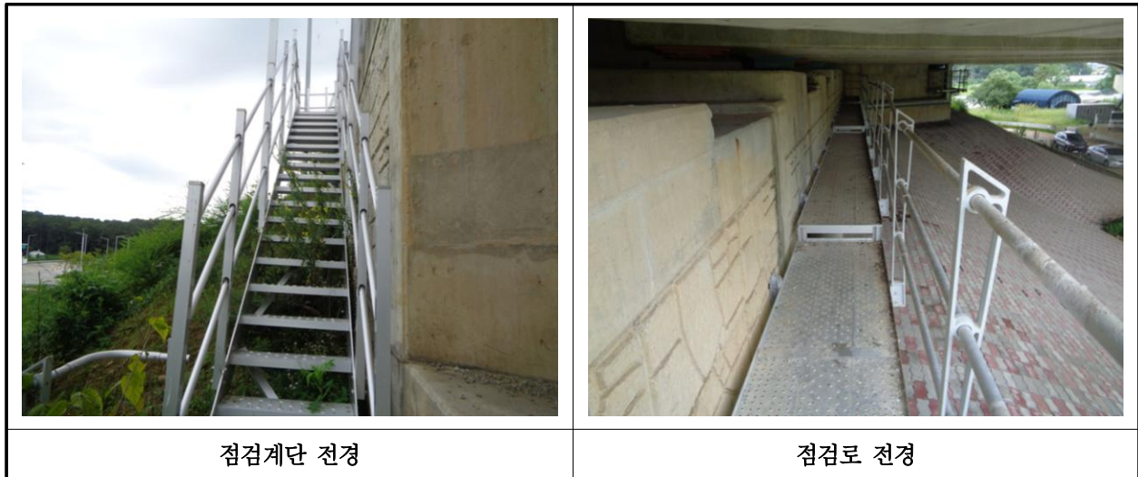
【사진 11.3.25】 교량 점검시설 전경
