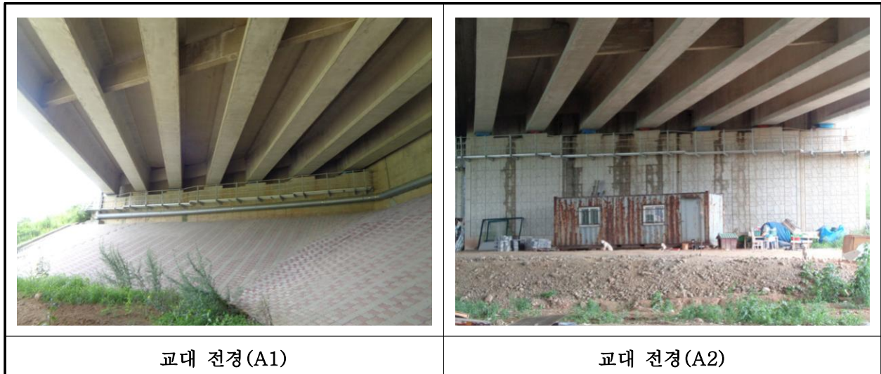
【사진 11.3.8】 교대 전경
